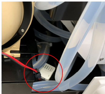
例) 透析装置内への設置
